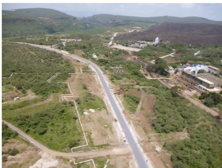
Figure 24 : Vue aérienne de l'une des unités (2x70MWe) de KenGen (Kenya) à Olkaria: chaque centrale connecte un réseau de vapeur à partir de puits forés à 2500-3000 mètres de profondeur
